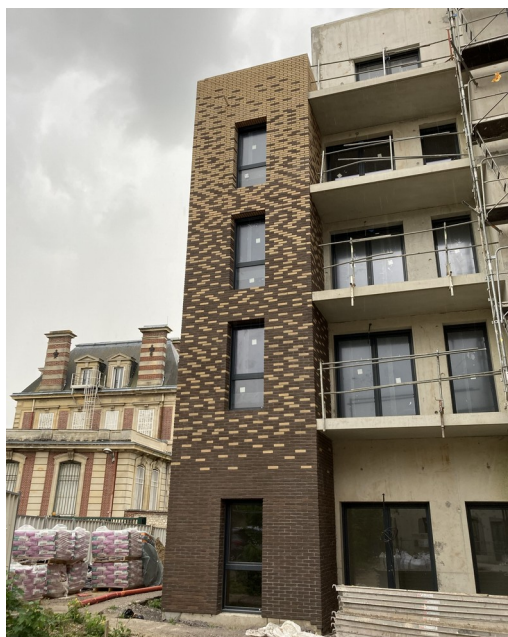
RSS Icade - Boulevards Joffre et Ferry, Louviers Vue extérieure
