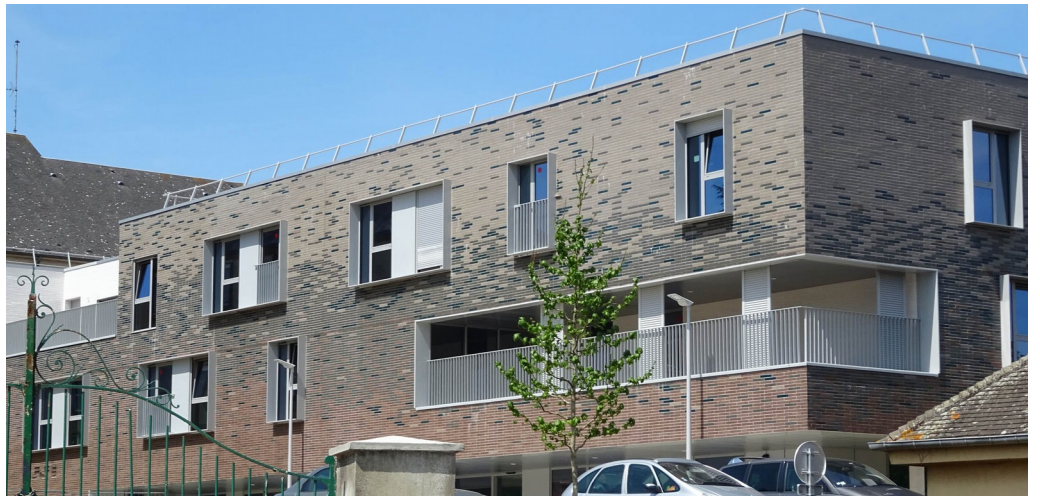
Vue sur l'EPHAD de Rugles et ses motifs aux 14 couleurs de parement de brique
